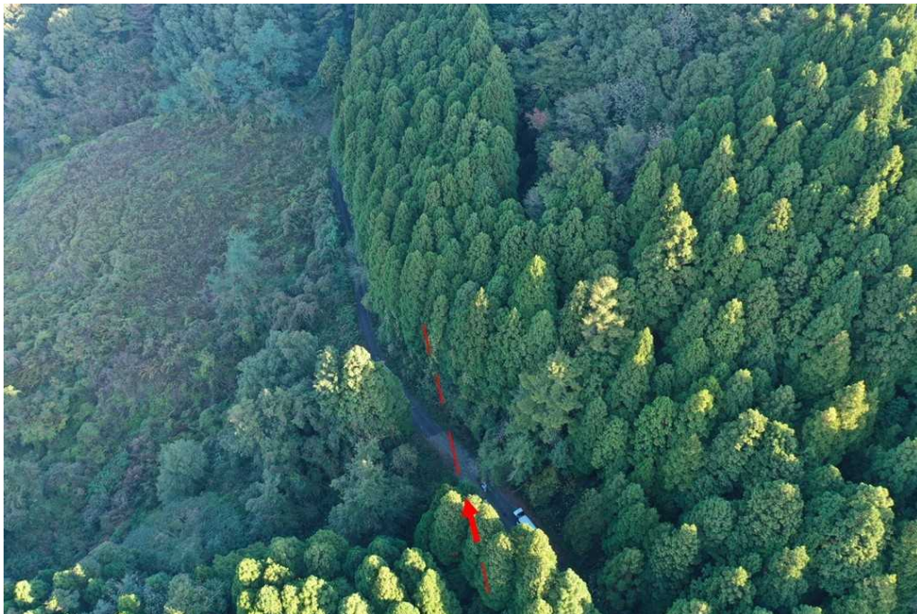
写真3：道路面に確認される地震断層周辺の地形（2024年11月10日撮影）
