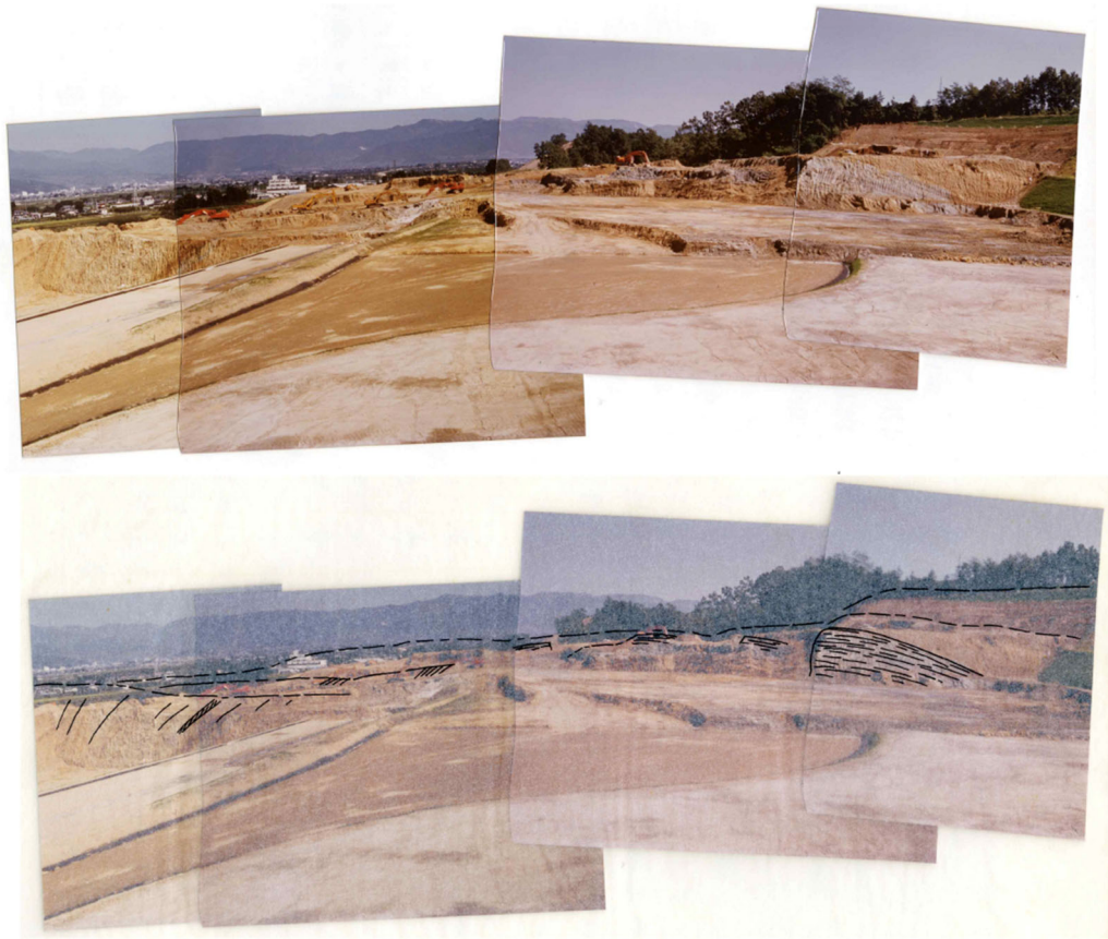
図1 中央自動車道の建設工事によって露出した数百 m の短い波長を持つ非対称な背斜構造. 2 枚の写真は, 澤 (1982MS) によって撮影及び加筆されたものである.
