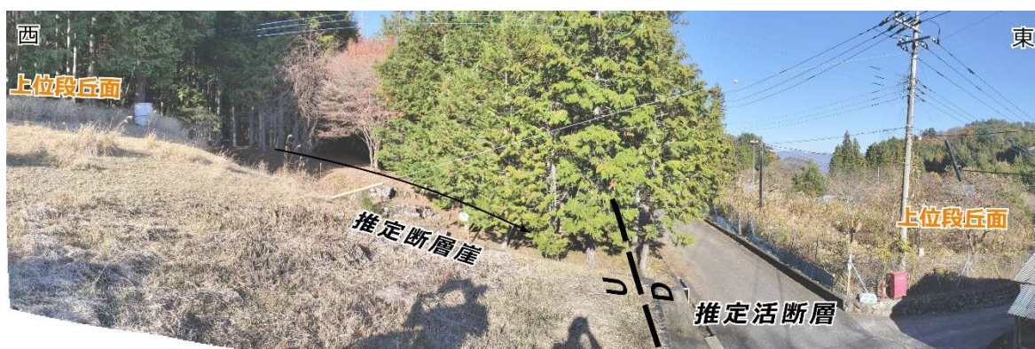
写真2 早川町笹走付近の断層崖 (2024 年 12 月 3 日筆者撮影)。
