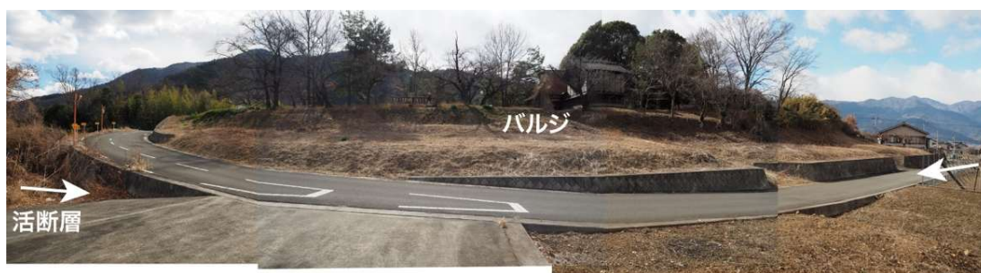
写真 1 芦川左岸段丘面上のバルジ（東側のバルジを北から撮影） （2025 年 2 月 4 日 山中撮影）
