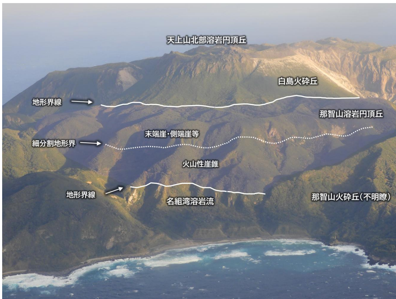
写真-24 那智山溶岩円頂丘の遠景（神津島西の上空から東方向を撮影）
