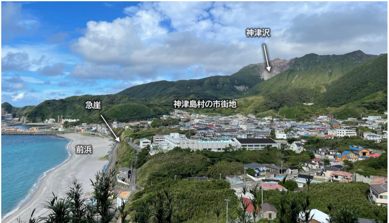
写真-10 天上山火砕流堆積面の遠景（図-9 中に示した撮影地点・方向にて撮影）
