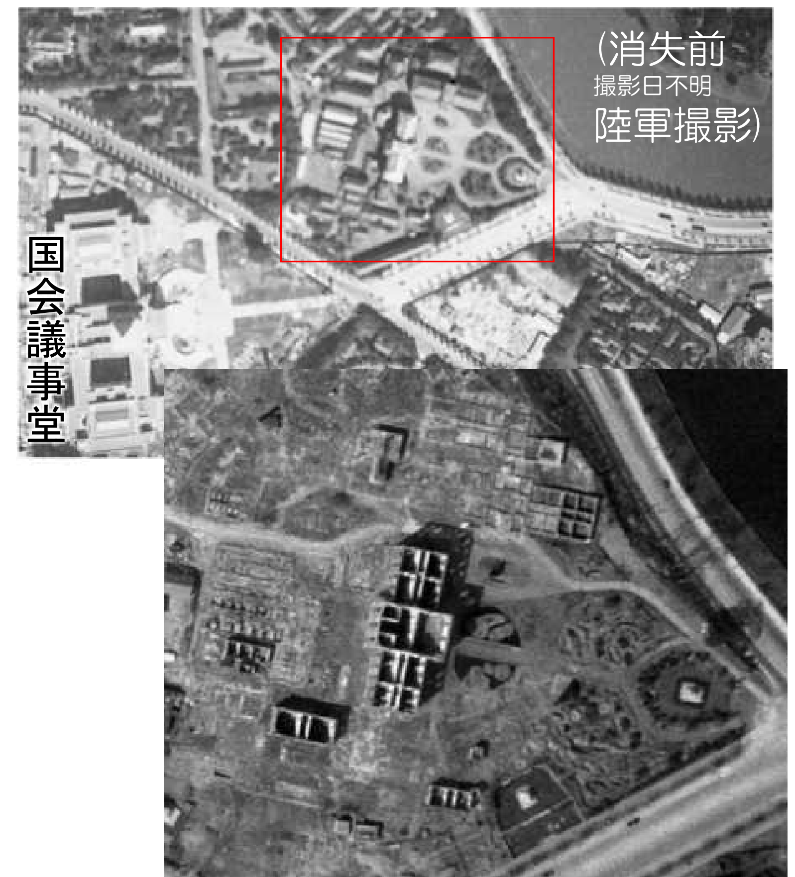
陸地測量部の焼跡 (1947年11月米軍撮影)
