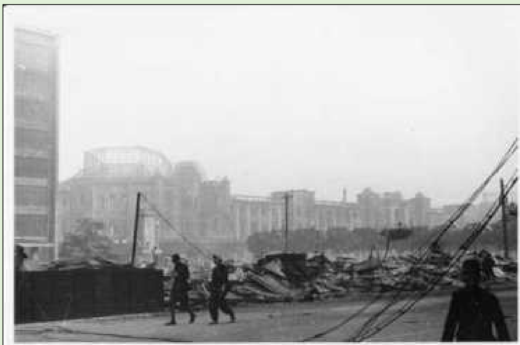
焼失した東京駅 千代田区 昭和20年5月
