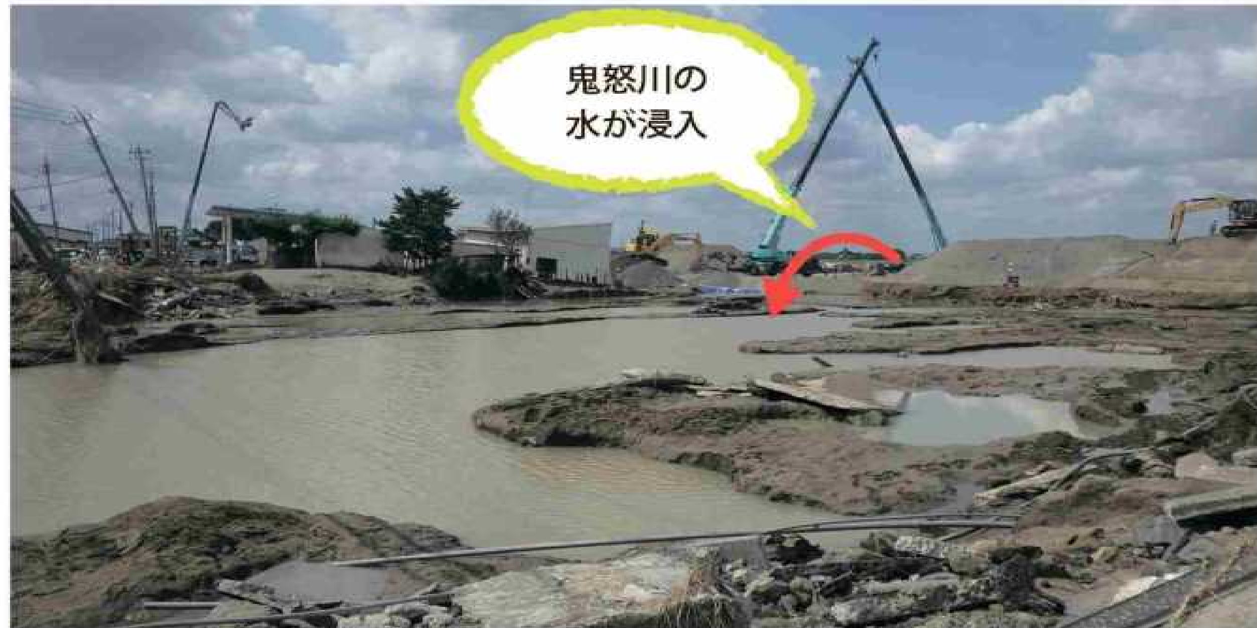
写真1-11 平成27年9月関東・東北豪雨災害による常総市の堤防決壊現場（奥のクレーン車のあたりが決壊箇所）
