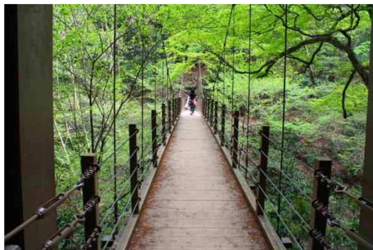
高尾山4号路つり橋
