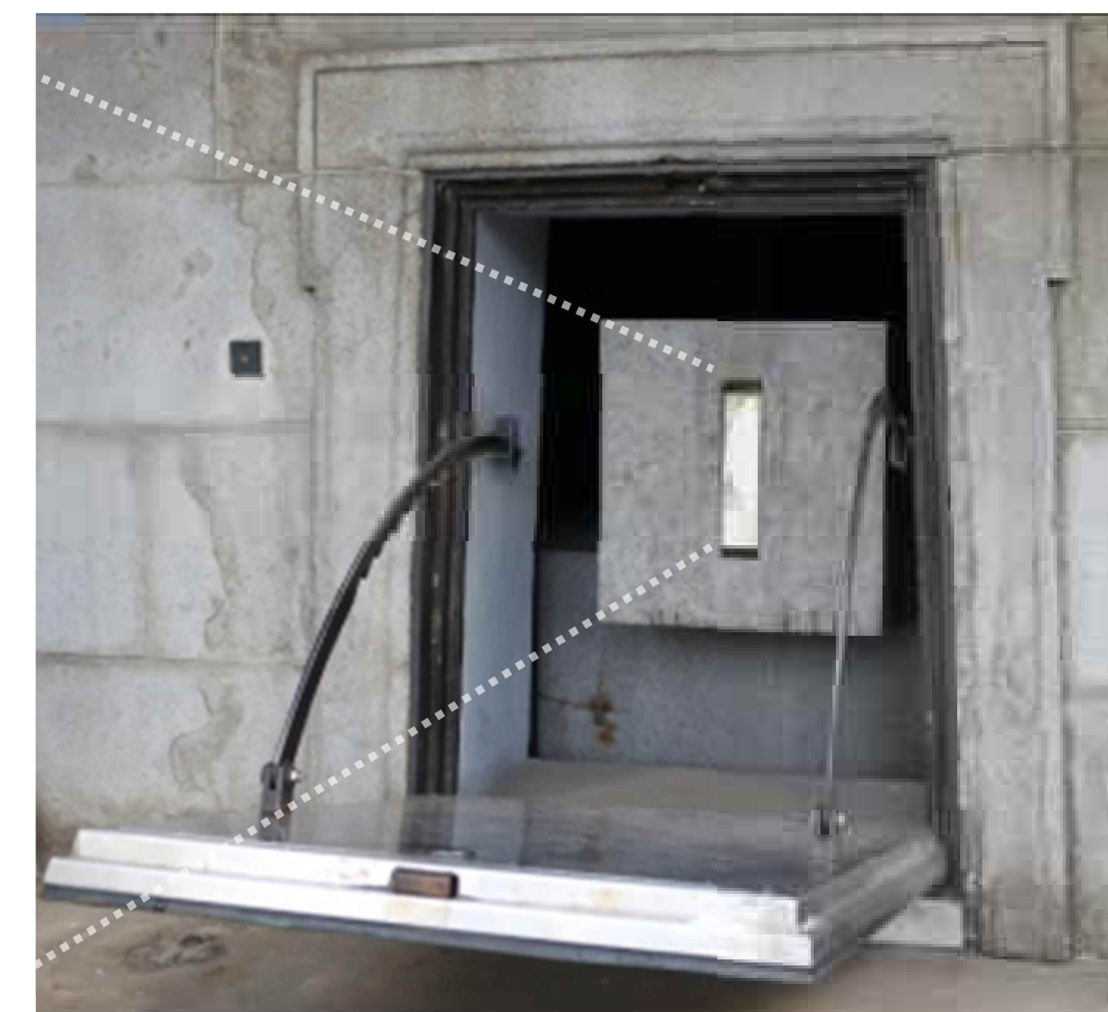
日本水準原点（零位を示す水晶板）
