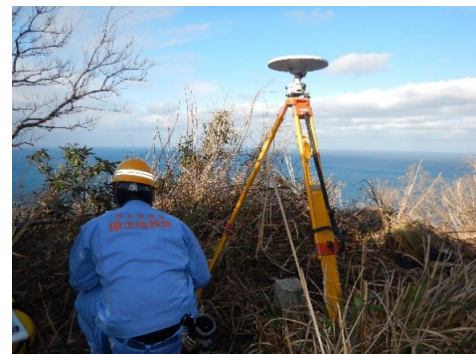
三角点での復旧測量
