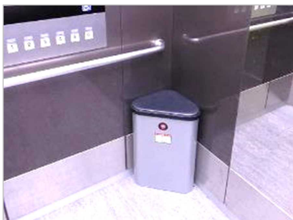
エレベーター非常用キャビネット（本院）
