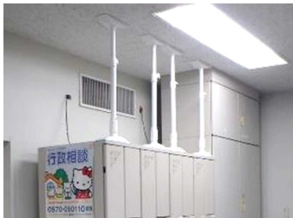
突っ張り棒（北陸地方測量部）
