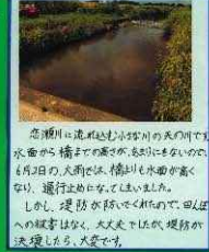
志瀬川と川沿いの斜面は、大雨が降ると、土砂が崩れやすくなります。この斜面は、土砂災害特別警戒区域に指定されています。この斜面の形状は、大雨が降ると、土砂が崩れやすくなります。この斜面の形状は、大雨が降ると、土砂が崩れやすくなります。
