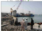
相馬港における護岸工事
