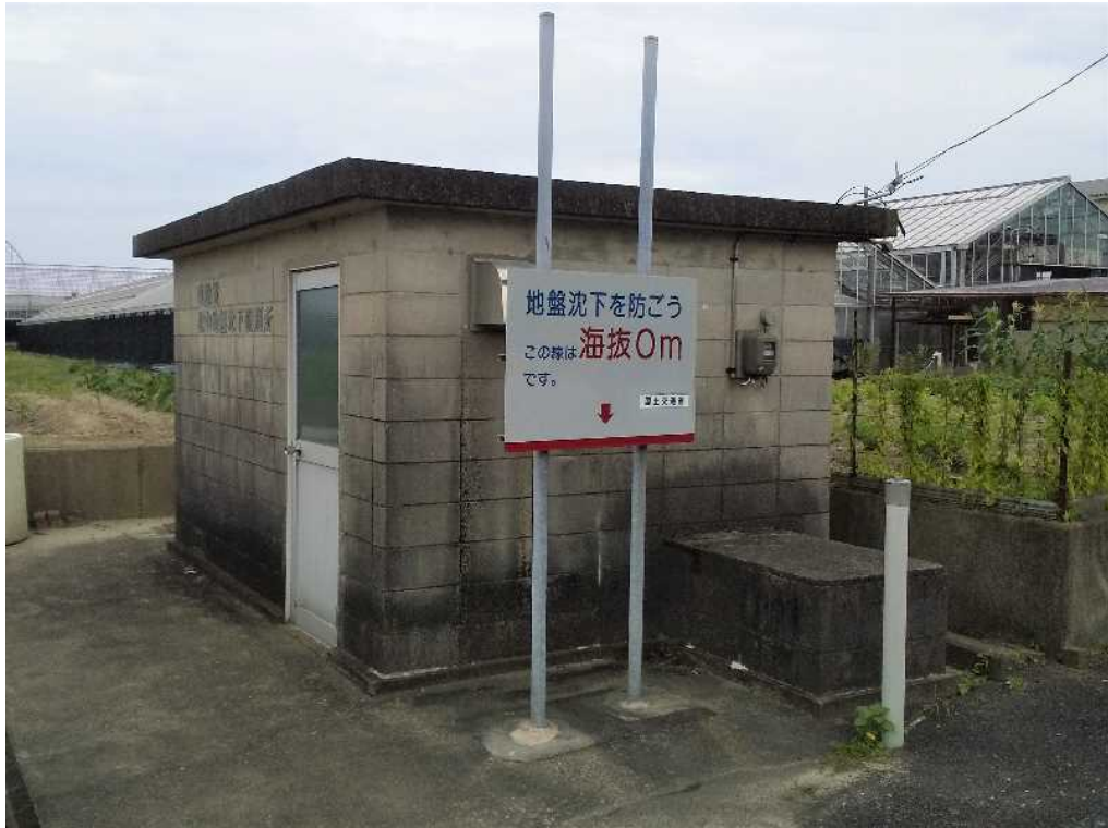
写真-7 三重県桑名市長島町松蔭 松中地盤沈下観測所の海水面レベルの表示（令和3年6月撮影）
