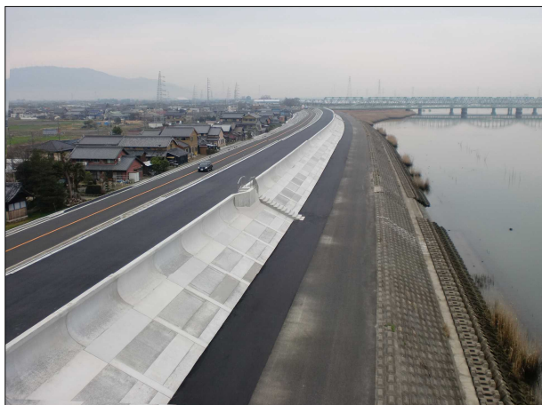
高潮堤防の遠景(平成22年3月撮影)
