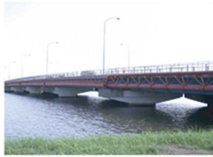
新善太川橋水管橋
