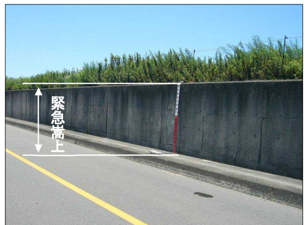
緊急的に嵩上げた波返工(昭和61年度完成) (平成19年撮影)
