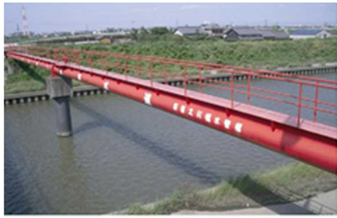
新善太川橋水管橋
