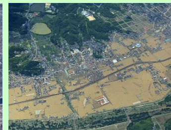
令和元年東日本台風 （長野市）
