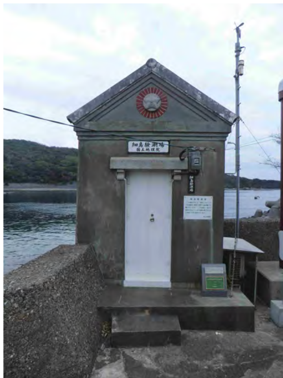
■ 明治25年（1892）に建てられた細島験潮場
