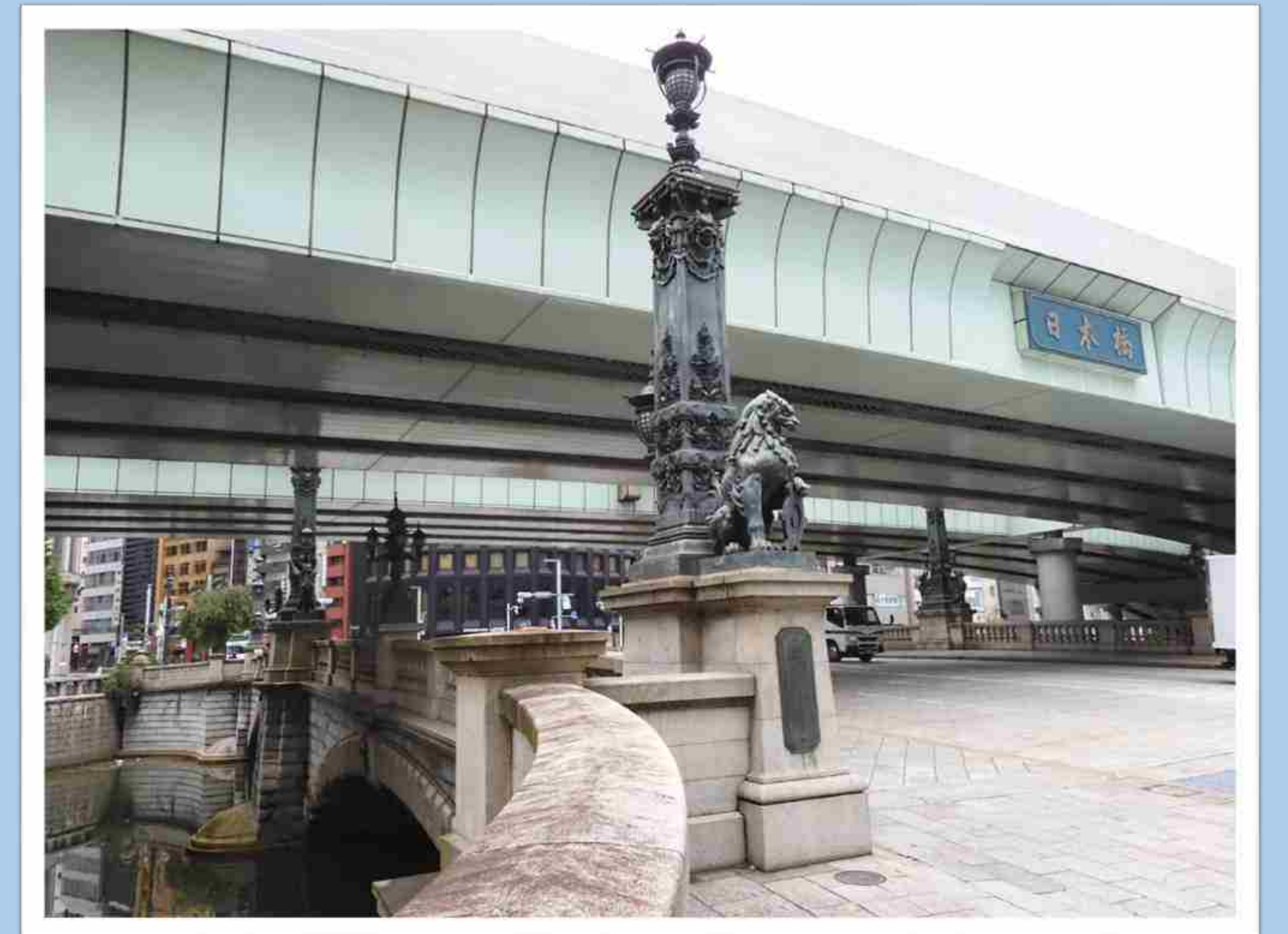
日本橋から見た首都高速道路
