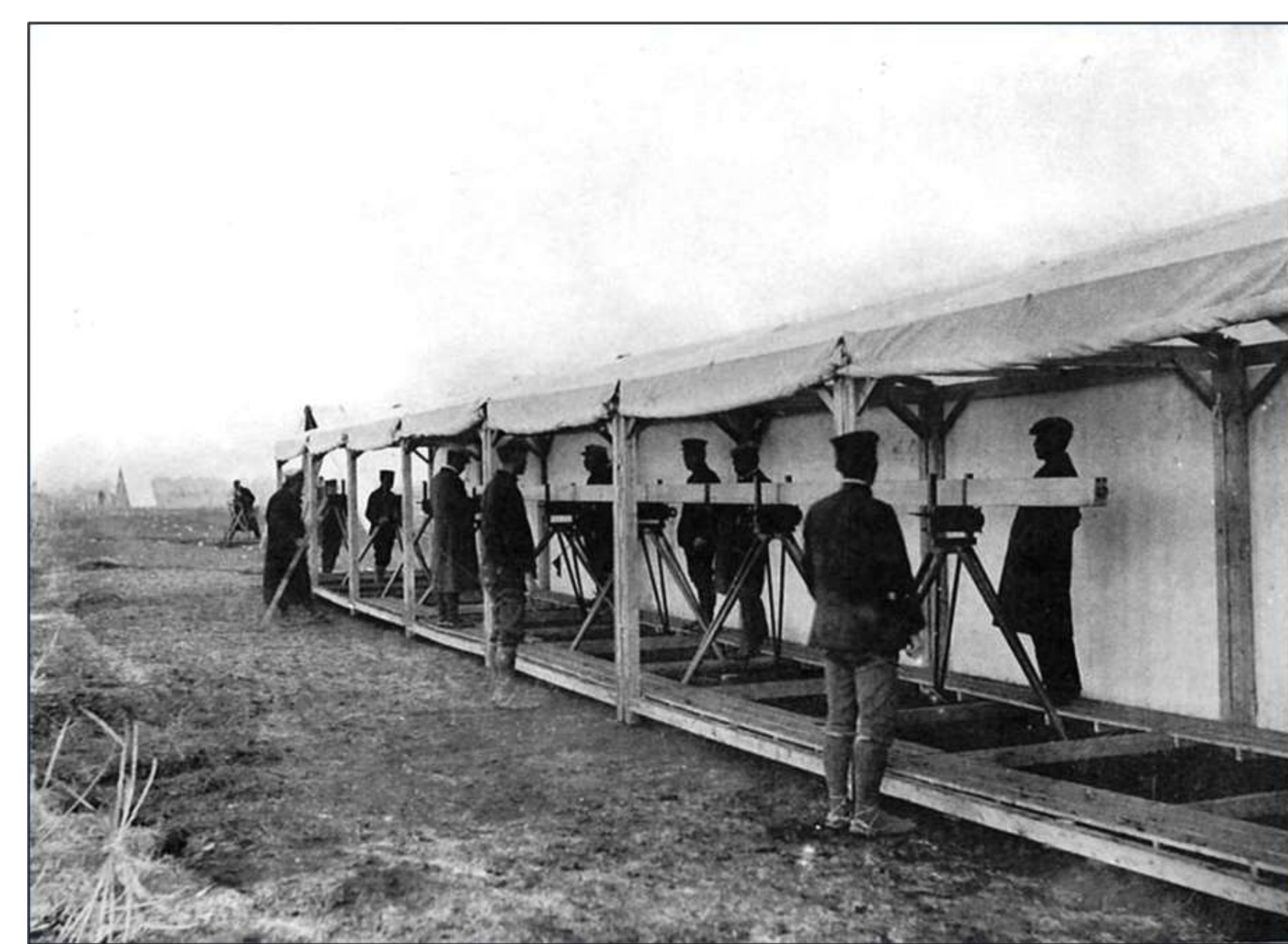
ヒルガード基線尺の測定風景 明治43年（1910）相模野基線
