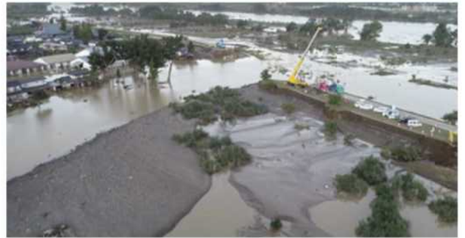
長野県長野市大字穂保付近の被害箇所1（令和元年10月13日撮影）
