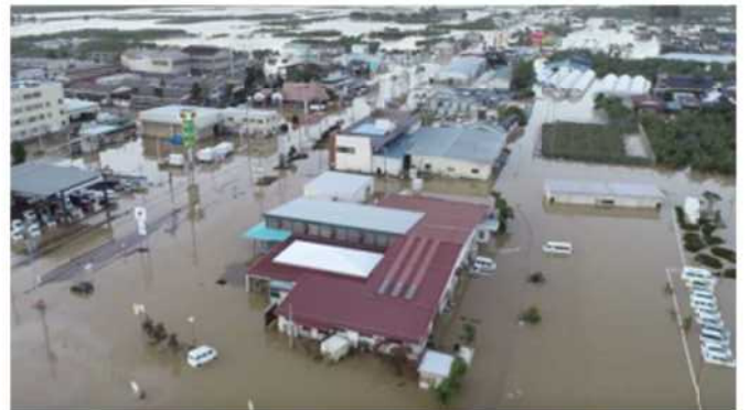
長野県長野市大字大町付近の被害箇所（令和元年10月13日撮影）
