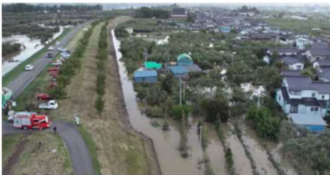
長野県長野市大字穂保付近の被害箇所2（令和元年10月13日撮影）
