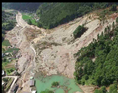
7月13日の日田市小野地区の斜面崩落現場
