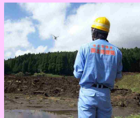
直営でマルチコプター型UAVによる緊急撮影を実施
