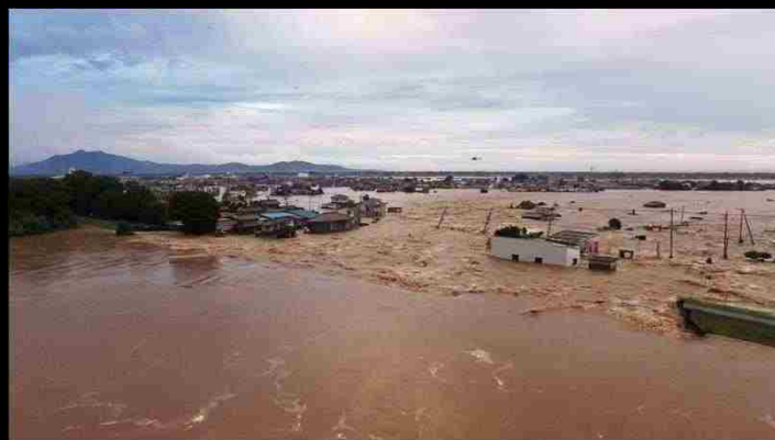
茨城県常総市の鬼怒川破堤箇所 9月10日の破堤4時間後の様子
