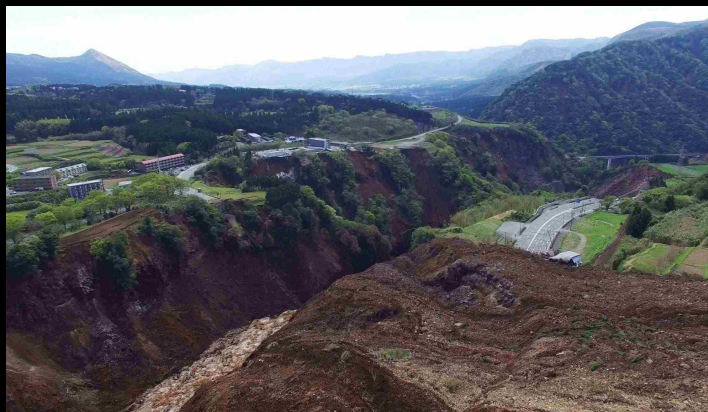
熊本県南阿蘇村の阿蘇大橋崩落現場 本震直後の4月16日に撮影を実施
