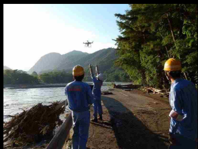
道の駅いわいずみの西 流出した国道455号の路盤
