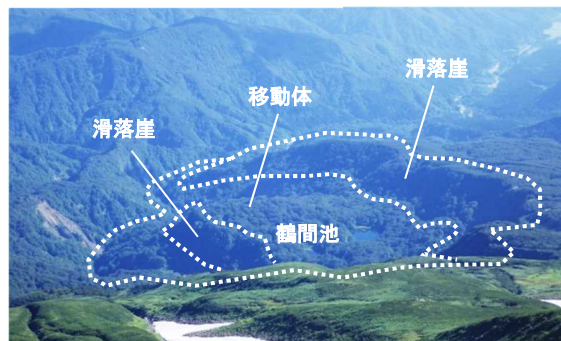
写真 68 地すべり地形（鶴間池周辺）
