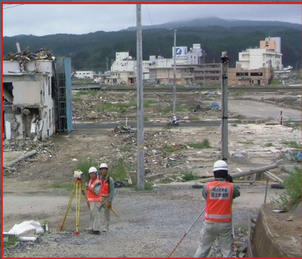
東北地方太平洋沖地震後の高さを測る緊急測量
