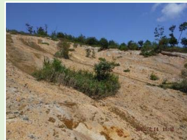
斜面上の落ち残り
