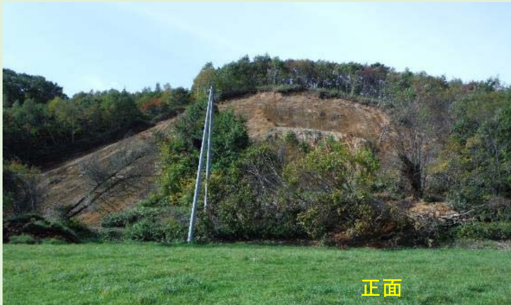
I -a' 斜面崩壊・表層すべりタイプ
