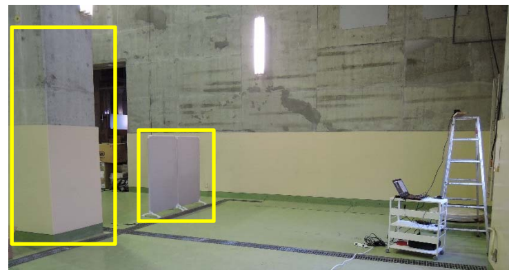
国土地理院 排水処理場
