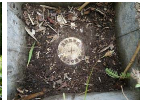
道路基準点 (検証点として利用)
