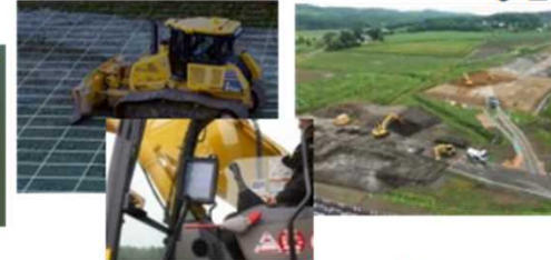
ICT建機での施工
