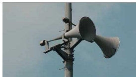
水防サイレン
