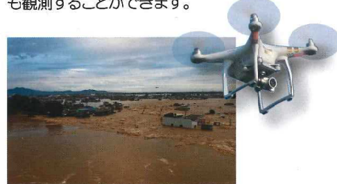
UAV で撮影した鬼怒川の堤防決壊現場（2015 年 常総市）
