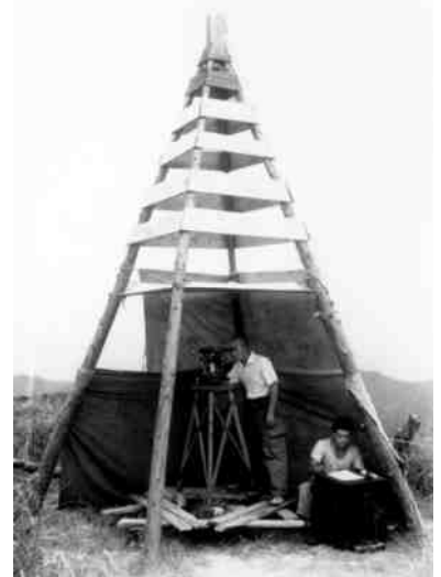
三角点の上に目標のやぐらをつくり測量をしていました。 50年くらい前までは三角測量が主流でした。
