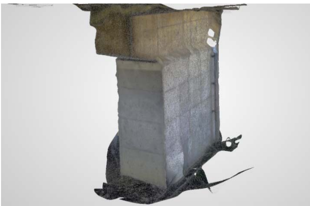
図-13 SfMによる既設構造物(橋脚)のモデル作成
