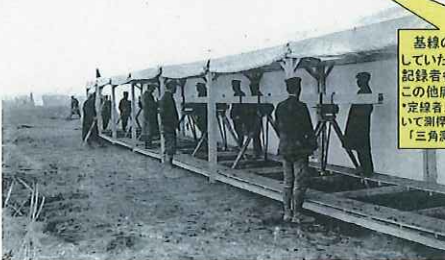
写真:相模野基線におけるヒルガード式測桿(4m)3本を用いた基線測量 ヒルガード測桿は、1877年(明治10)米國海岸測量局技師ヒルガード(J.E.Hilgard)氏の考案によって製造され、二等基線測量に使用されたものであるが、陸地測量部では実験の結果成績良好と判断し、基線測量に使用することとした。「相模野基線測量」明治43年測地学会報告より
