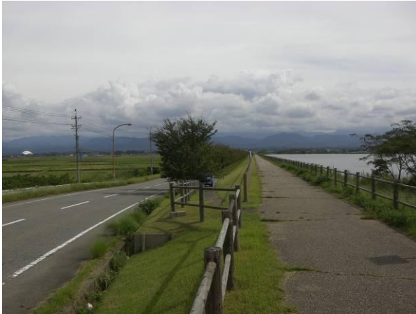
写真-27 柴山潟干拓地締め切り堤防
