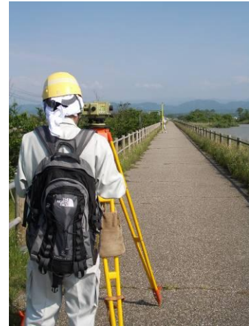
写真－10 柴山潟のベンチマーク高の水準測量
