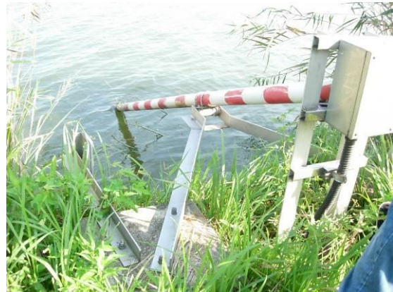
写真－ 19 金沢河川国道事務所の木場潟 水位観測所
