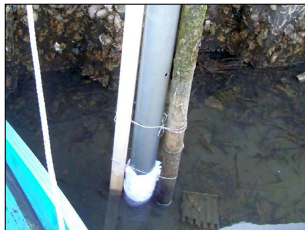
写真8-2 水位計センサー設置状況
