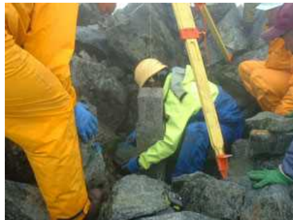
剱岳山頂での三角点設置(埋設)作業(8月24日)
