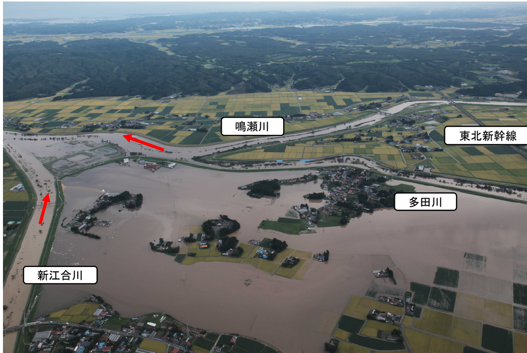
新江合川、鳴瀬川の合流地点付近の 浸水状況
