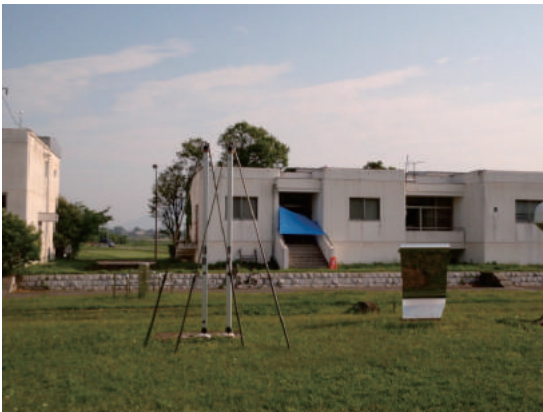
写真-1 温度特性試験地（天文棟付近）
