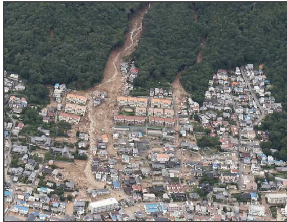
被災日(8月20日)に撮影した斜め写真(八木地区)
