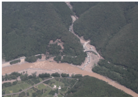
写真-1 斜め写真（北川村の法面崩壊付近拡大）
