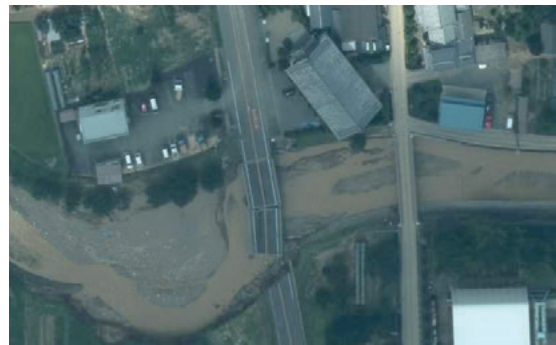
写真-2 垂直写真(国道175号八日市橋の落橋付近拡大)
