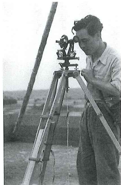
写真 昭和26年頃の作業風景
