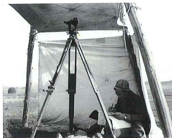
写真2 昭和26年頃の作業風景
