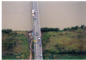
十勝川河口橋上流方向に最大67cm移動
