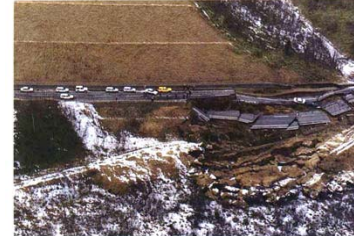
図11-133 釧路沖地震による路肩崩壊(厚岸町糸魚沢の国道40号線) (1993年1月16日、国土院コンテス撮影)
