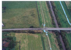
浦幌町仁頃川に架かる町道
