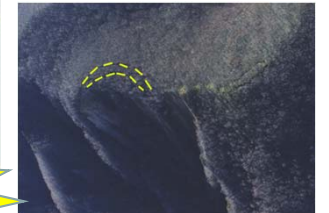
既存の崩壊地形に沿った亀裂
