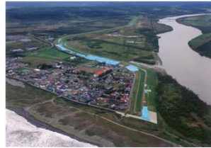
十勝川急湾の亀裂
