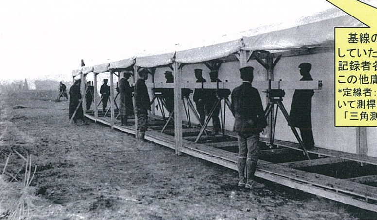
写真:相模野基線におけるヒルガード式測桿(4m)3本を用いた基線測量 ヒルガード基線尺は、1877年(明治10)米国海岸測量局技師ヒルガード(J.E.Hilgard)氏の考案によって製造され、二等基線測量に使用されたものであるが、陸地測量部では実験の結果成績良好と判断し、基線測量に使用することとした。「相模野基線測量」明治43年測地学委員会報告より
