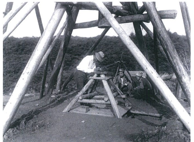
写真 中心上げが終了し、基線測量の開始
