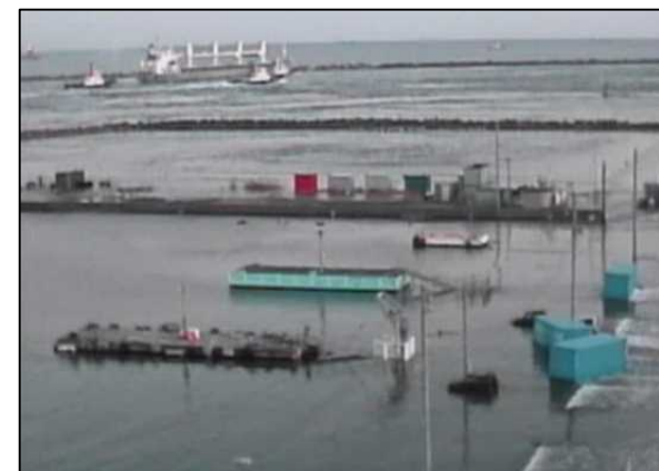
苫小牧港 (冠水状況)
