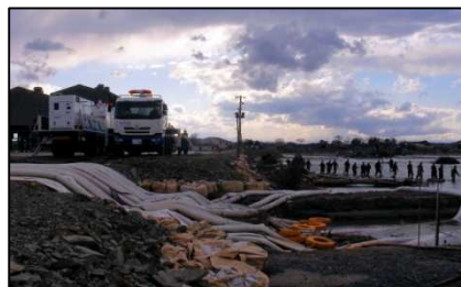
応急対策班 (排水ポンプによる排水作業)
