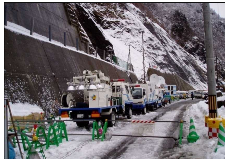
えりも斜面崩落
