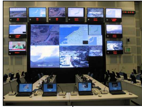
本省防災センター
