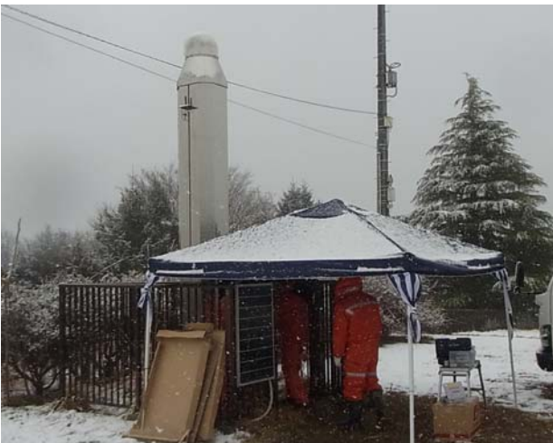
写真－2 電子基準点「河北」の応急復旧作業風景
