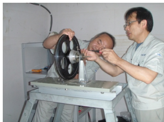
写真－11 福島県相馬港検潮所での験潮儀取り付け作業
