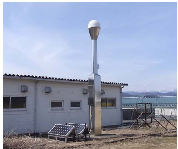
写真-1 電子基準点「白石」ソーラーパネル設置後
