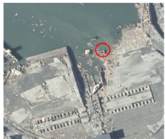
写真-6 空中写真による相馬験潮場の被災状況判読
