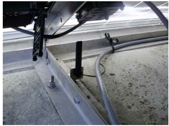
写真-15 福島県相馬港検潮所に設置したパケット通信アンテナ
