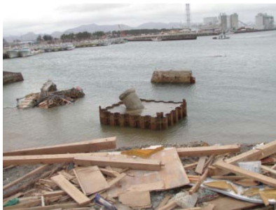
写真-3 相馬験潮場の被害の状況 相馬験潮場中央には傾斜した観測井戸のみ残る。（2011年4月19日撮影）
