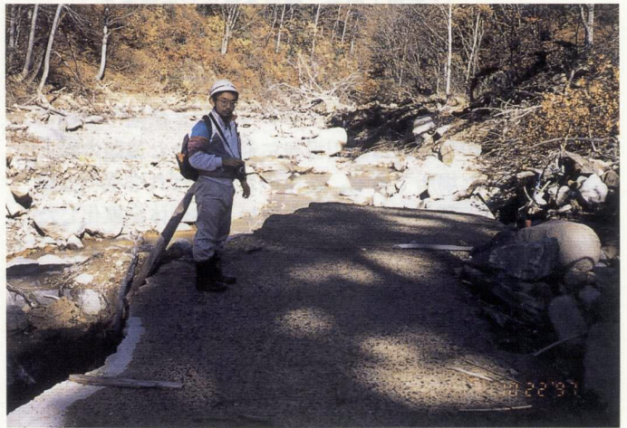
写真-15 かるうじて残った赤川温泉への道路（赤川右岸→下流）
