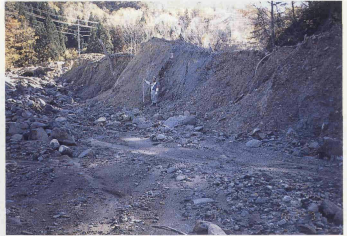
写真-10 岩屑なだれが側方浸食を受けた地形（赤川下流→上流） 崖の高さはおよそ4～5m
