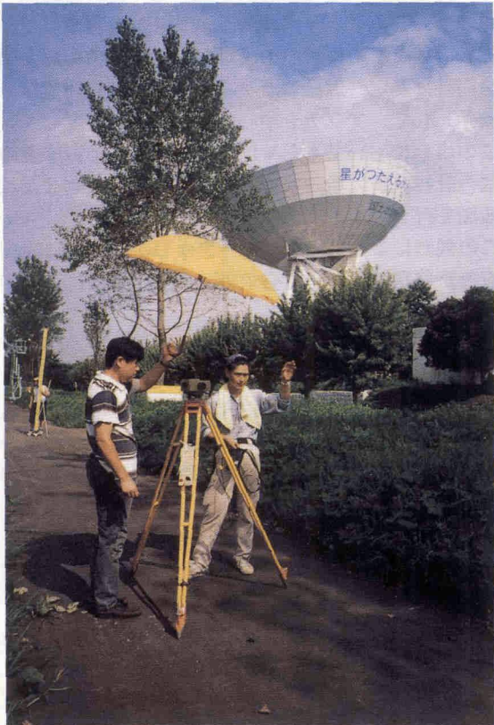
写真-6 水準測量風景
