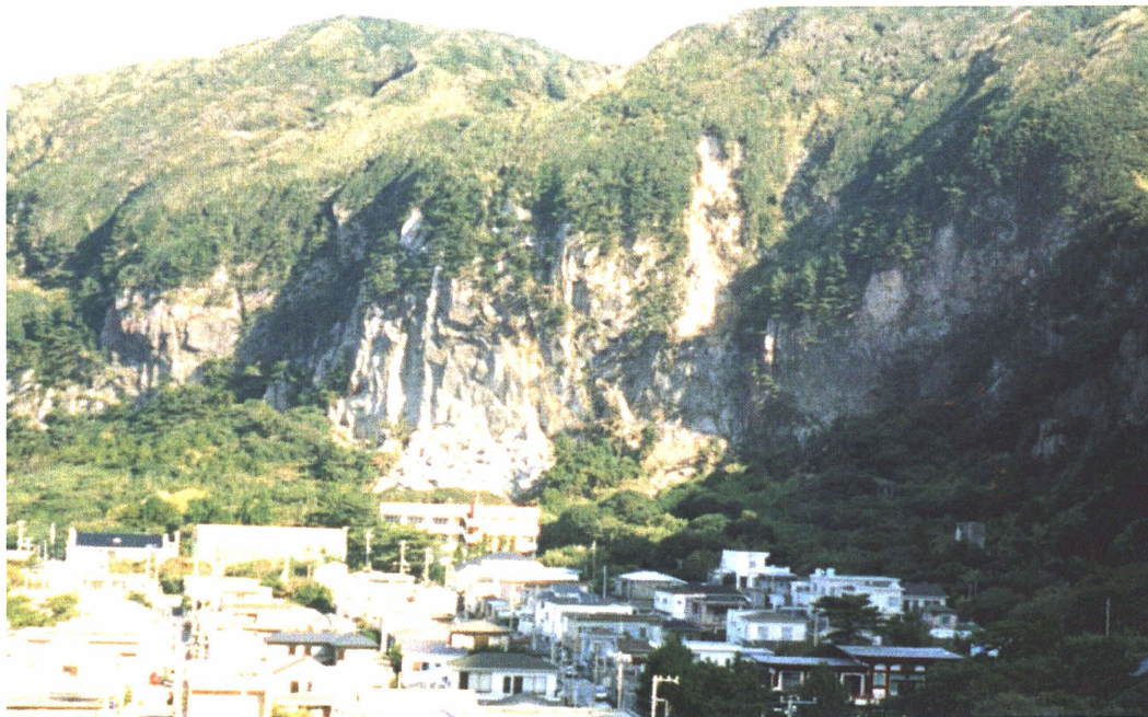
写真一 5 新島，若郷地区の崩壊の状況（平成12年12月2日撮影）
